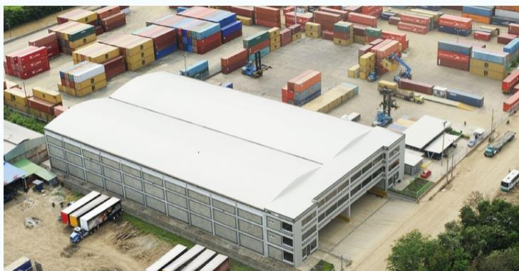
Bodega y Patio Contenedores Yumbo
