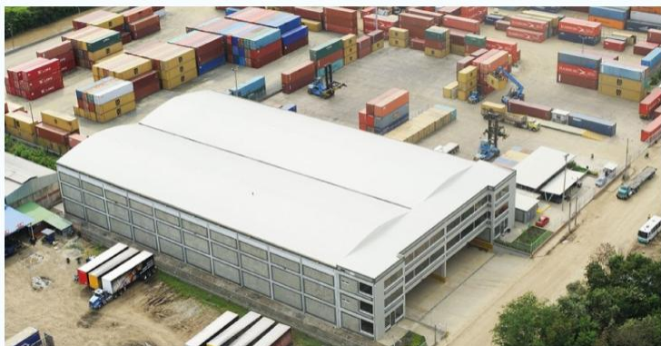
Bodega y Patio Contenedores Yumbo
